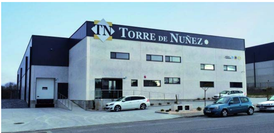
Fachada de una planta de Torre de Núñez. ()
